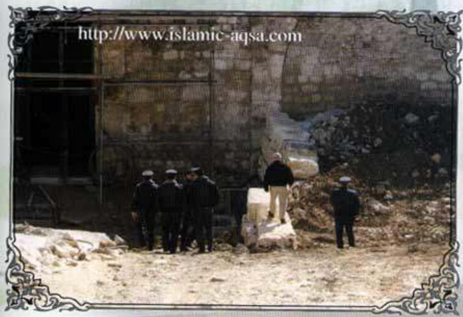
رصد لاعمال الحفر لبوابات المصلى المرواني
