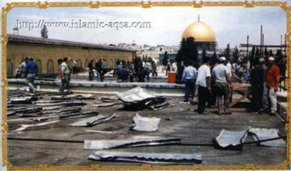
خلع الواح القصدير من فوق سطح المسجد الاقصى لتركب من جديد بعد صيانتها لمنع تسرب مياه الامطار ٢٠٠١/٥-٤
