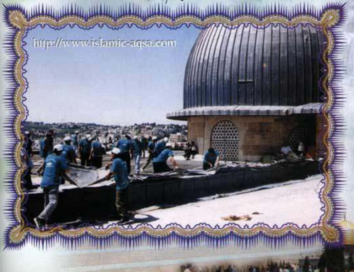
خلع الواح القصدير من فوق سطح المسجد الاقصى لتركب من جديد بعد صيانتها لمنع تسرب مياه الامطار ٢٠٠١/٥-٤
