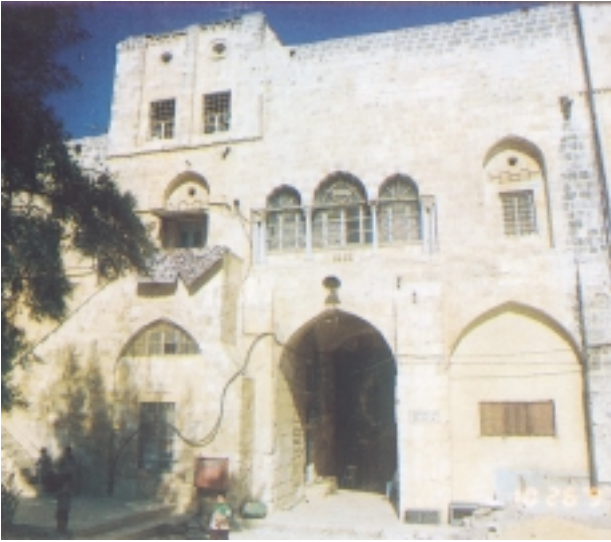
الواجهة الجنوبية للمدرسة الأمينية (Burgoyne 1987)
