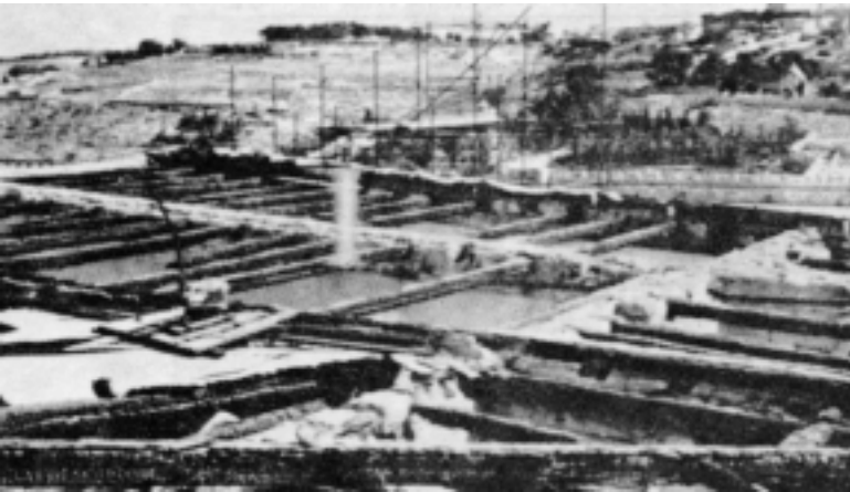
سطح المسجد الأقصى المسقوف بعد الحريق
